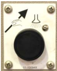
Figur [Figure] 8: Knap til manuel skylning af tilførsel [Manual Supply Flush button]
