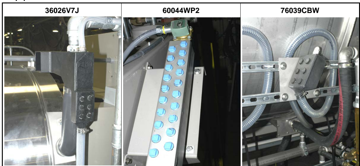
Σχήμα 9: Πολλαπλές εισαγωγής χημικών ουσιών για συστήματα αντλιών χημικών ουσιών. Βλέπε δήλωση προσοχής [25] . Αυτά είναι μόνο παραδείγματα. Το μηχάνημά σας ενδέχεται να είναι διαφορετικό.
