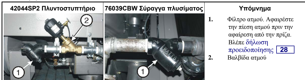
Σχήμα 12: Φίλτρο εισόδου ατμού. Αυτά είναι μόνο παραδείγματα. Το μηχάνημά σας ενδέχεται να είναι διαφορετικό.
