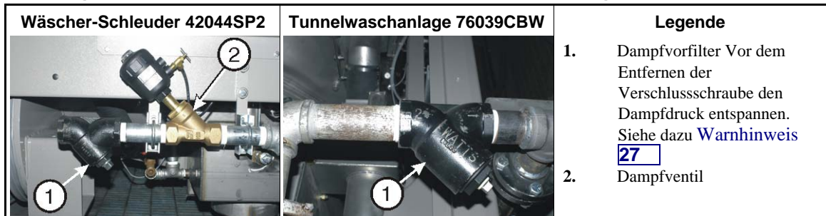
Abbildung 12: Vorfilter für Dampfzulauf Dies sind nur Beispiele, Ihre Anlage kann anders aussehen.
