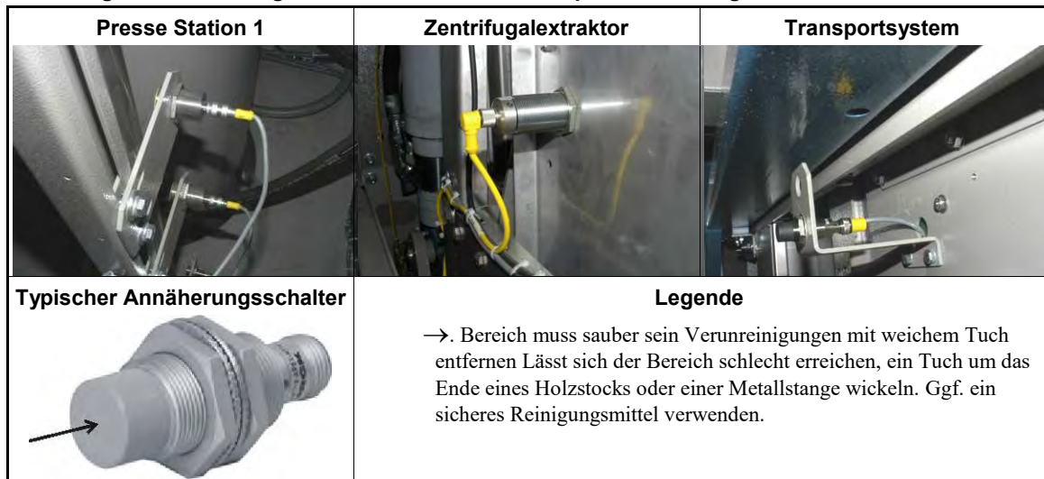
Abbildung 14: Annäherungsschalter Dies sind nur Beispiele, Ihre Anlage kann anders aussehen.
