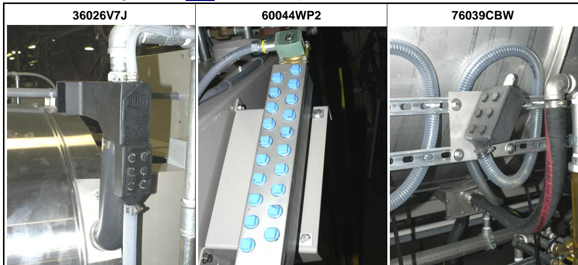
Figura 9: Colectores de entrada de químicos para los sistemas de bomba de químicos. Véase Declaración de precaución 25 . Estos son algunos ejemplos. El equipo puede ser diferente.
