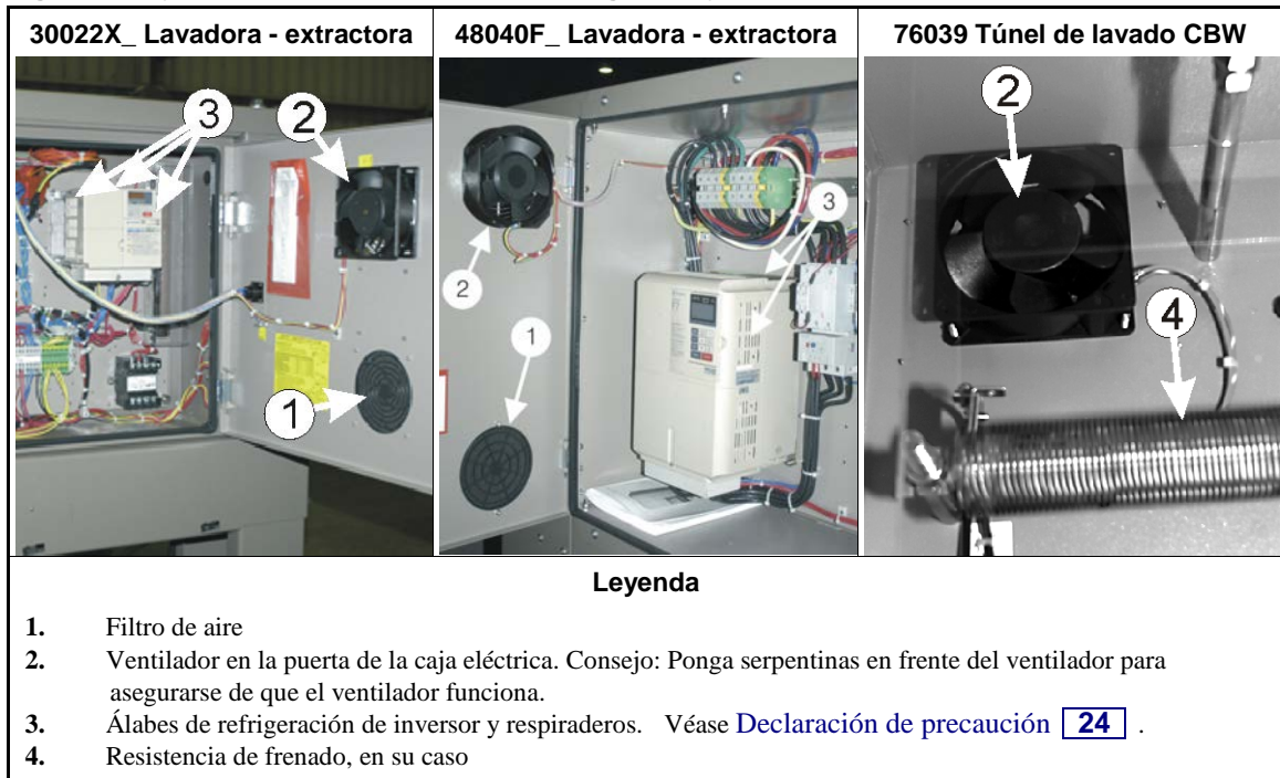
Figura 8: Caja eléctrica e inversor. Estos son algunos ejemplos. El equipo puede ser diferente.
