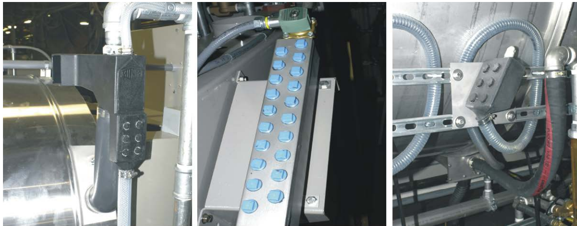
Afbeelding 4: Voorbeelden van verdelers voor chemische leidingen. Uw apparatuur kan er anders uitzien.
